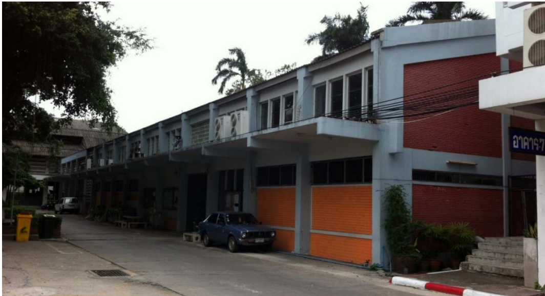
รูปที่ 7 ภาพถ่าย “อาคาร 8 (อาคารวิศวกรรมก่อสร้าง)” เมื่อปี พ.ศ. 2557 (ก่อนดำเนินการปรับปรุง)
