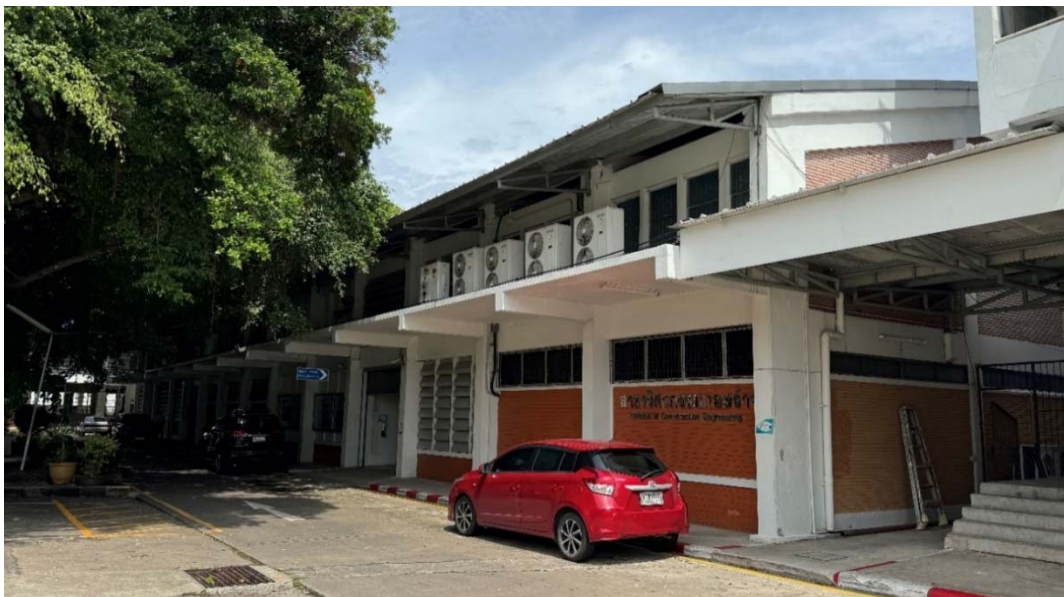
รูปที่ 8 ภาพถ่ายภายนอก “อาคาร 8 (อาคารวิศวกรรมก่อสร้าง)” เมื่อปี พ.ศ. 2567 (หลังดำเนินการปรับปรุง)
